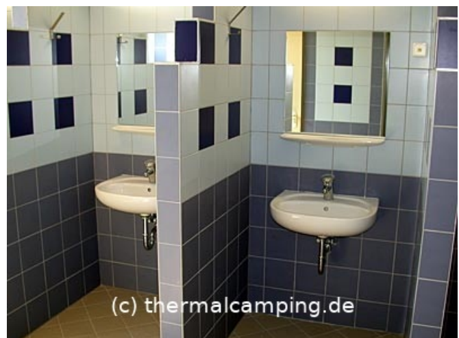
Waschbecken mit Zwischenwand
